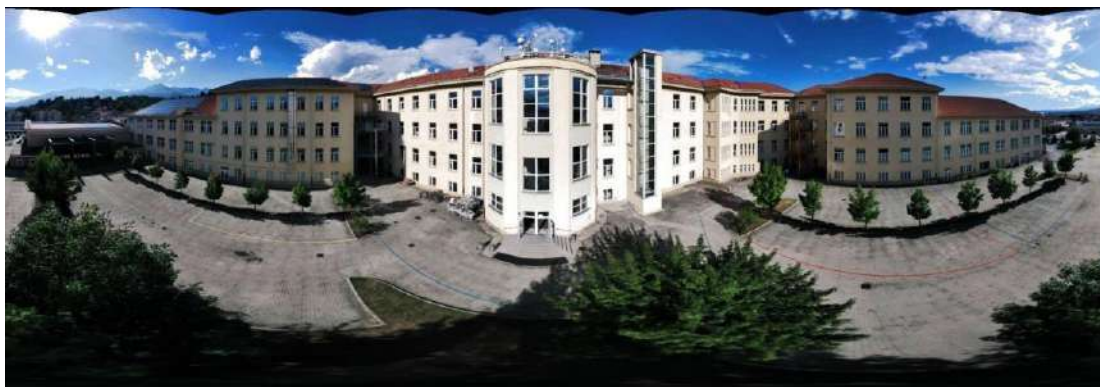
Figura 4 - Ripresa panoramica del cortile interno dell'ITIS Q. Sella ripreso dal Mavic 2 pro
