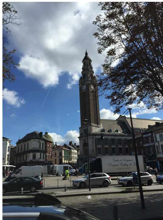
Fig. 16 La torre campanaria, Patrimonio Unesco.
