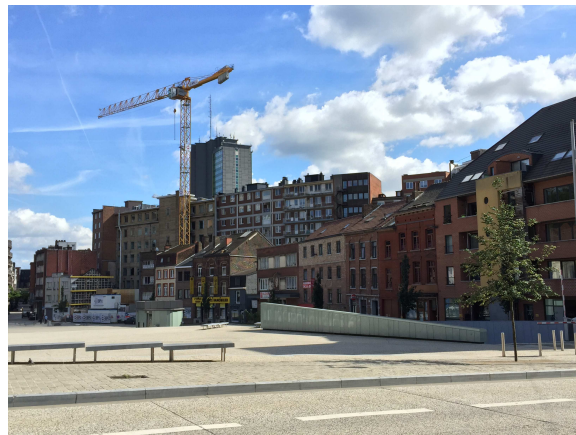
Fig. 15 Le case popolari e i cantieri che invadono il centro di Marcinelle
