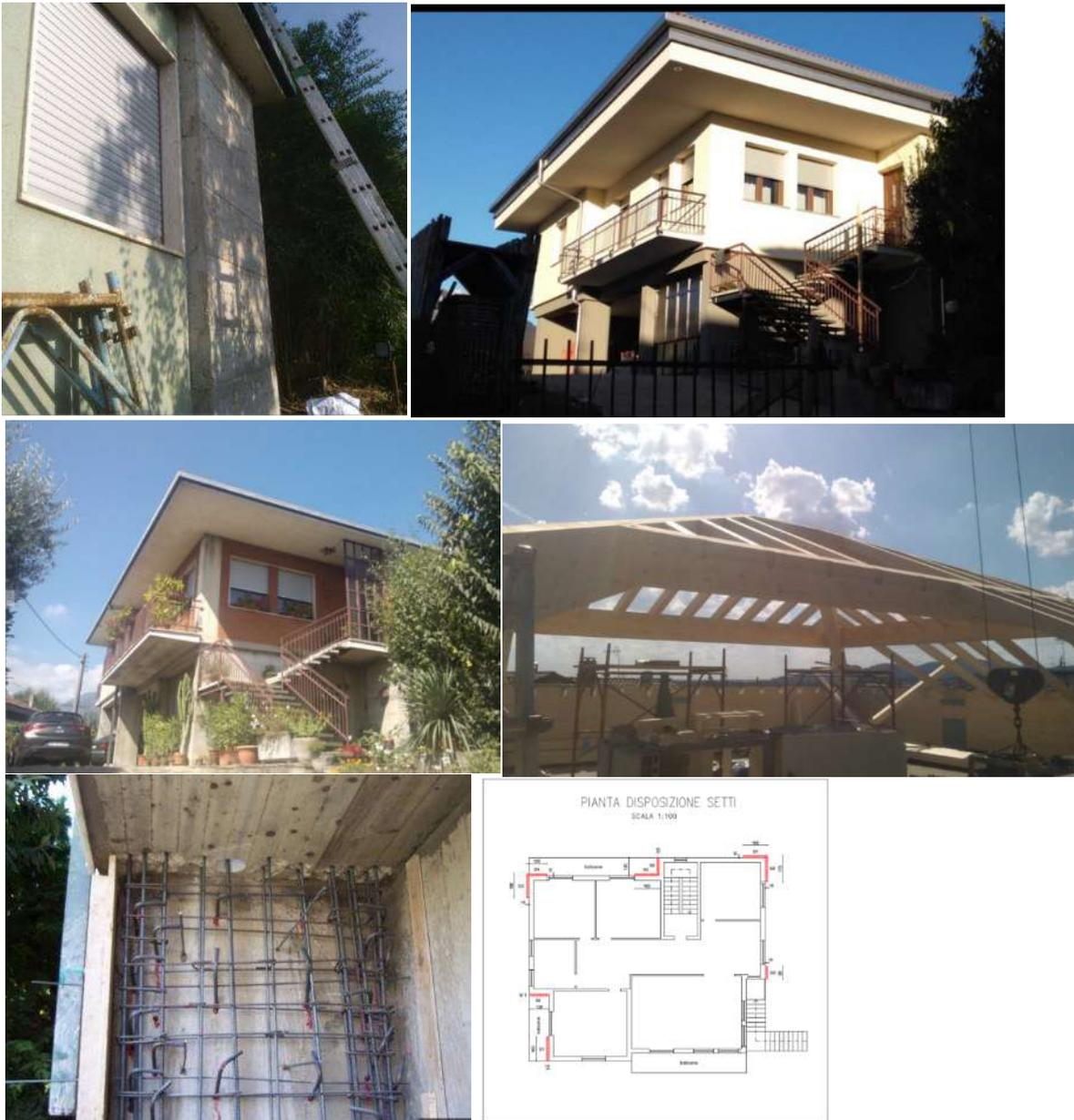
*Figura 42 - Adeguamento sismico con recupero del sottotetto e riqualificazione energetica di un fabbricato ad uso residenziale*
