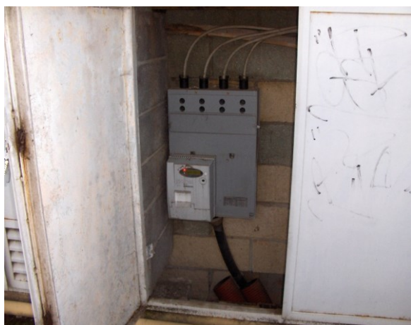
Contatore energia elettrica
