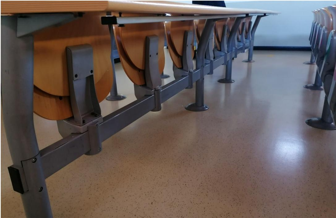
*Particolare sottobanchi aula tipo (fissaggio scatole ai montanti orizzontali)*
